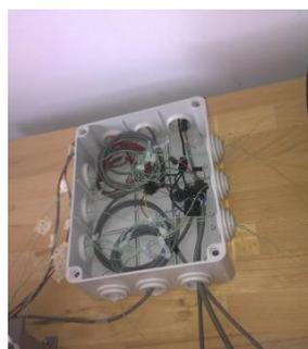
Figura III.15. Caja de derivación con la instalación eléctrica y los elementos de medida.
