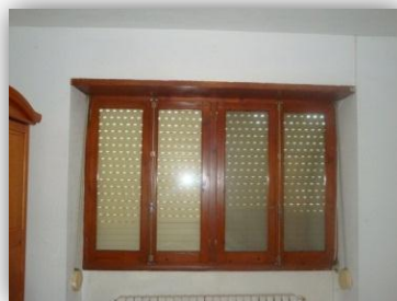
Imagen 37. Carpintería de madera de la vivienda 1. Fuente Propia
