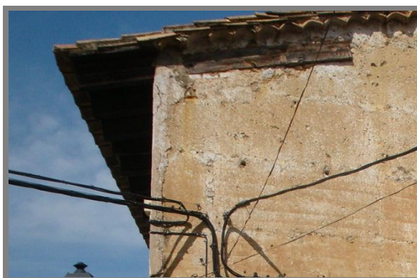
Imagen 25. Alero común de entablado de madera sobre rollizos en Forcall. Fuente Propia
