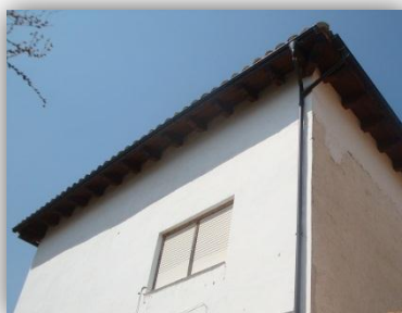
Imagen 38. Cubierta inclinada de la vivienda 1. Fuente Propia
