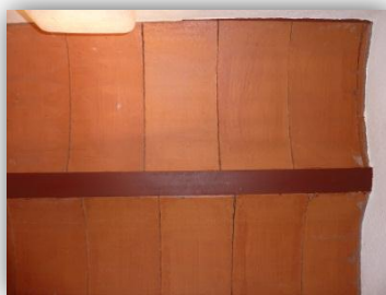
Imagen 56. Forjado de planta primera de la vivienda 3. Fuente Propia
