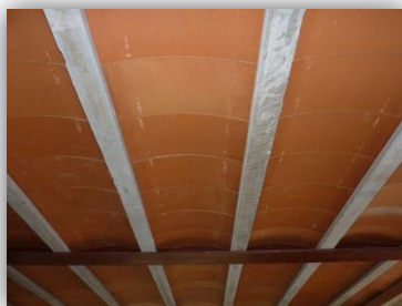
Imagen 47. Forjado de la vivienda 2. Fuente Propia
