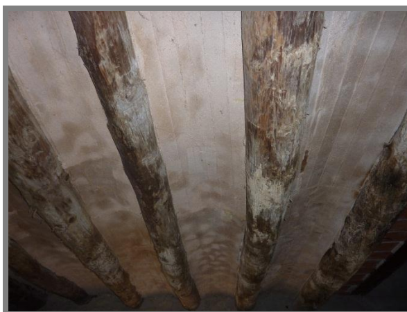
Imagen 27. Ejemplo de forjado típico en Forcall. Fuente Propia
