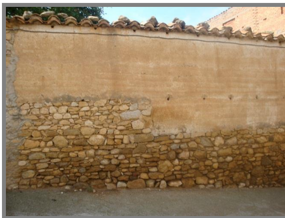
Imagen 24. Vivienda con zócalo de mampostería en Forcall. Fuente Propia
