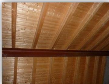
Imagen 49. Cubierta de la vivienda 2. Fuente Propia
