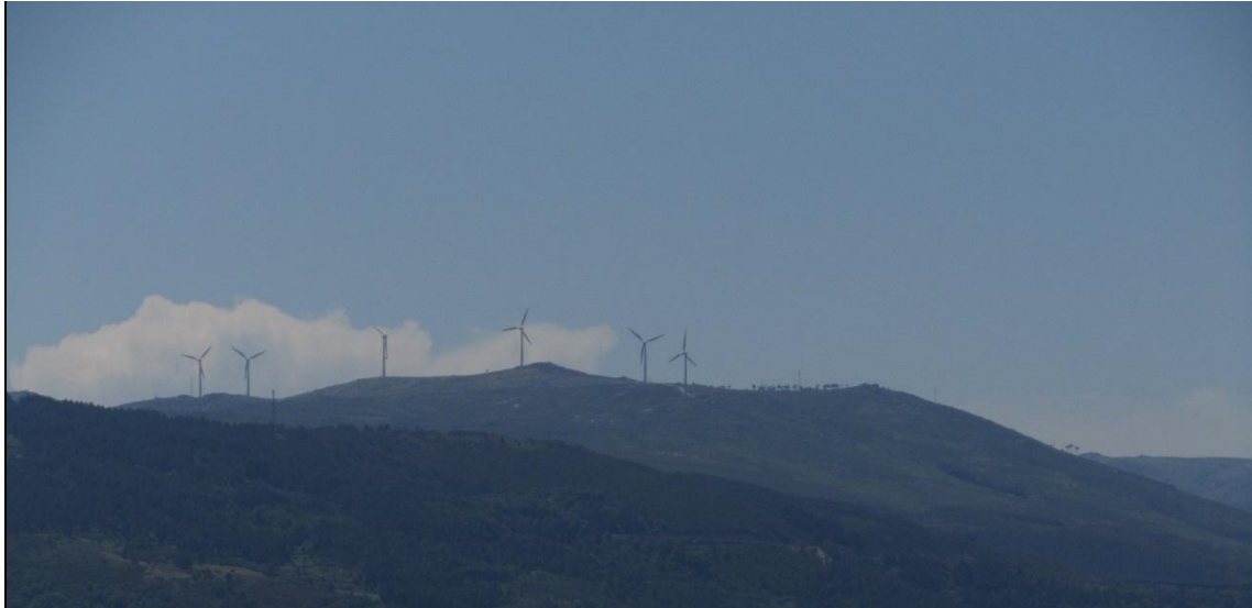
Fotografia7. Pás eólicas nas zonas de maior altitude
