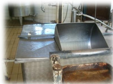
Figura 9 – Equipamento de filtração visto por cima.
