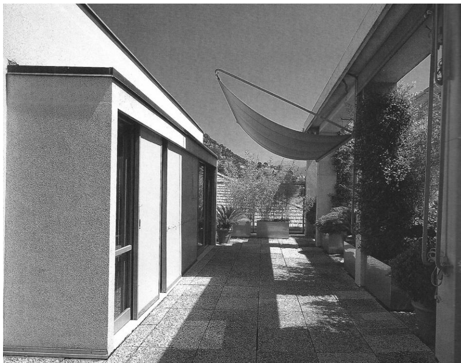
85 Foto actual do mecanismo de protecção solar na cobertura do edifício - Casa d'Affito - CASA CATTANEO, 2005
