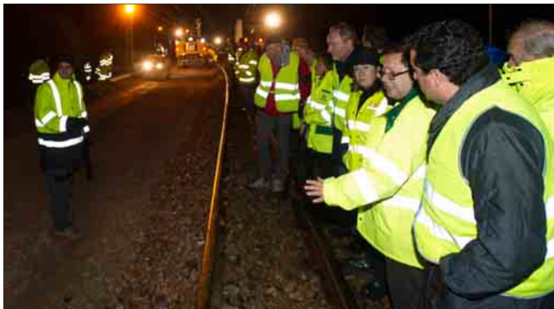
La ministra Ana Pastor durante la visita a las obras en Nules durante la madrugada pasada. EL MUNDO
