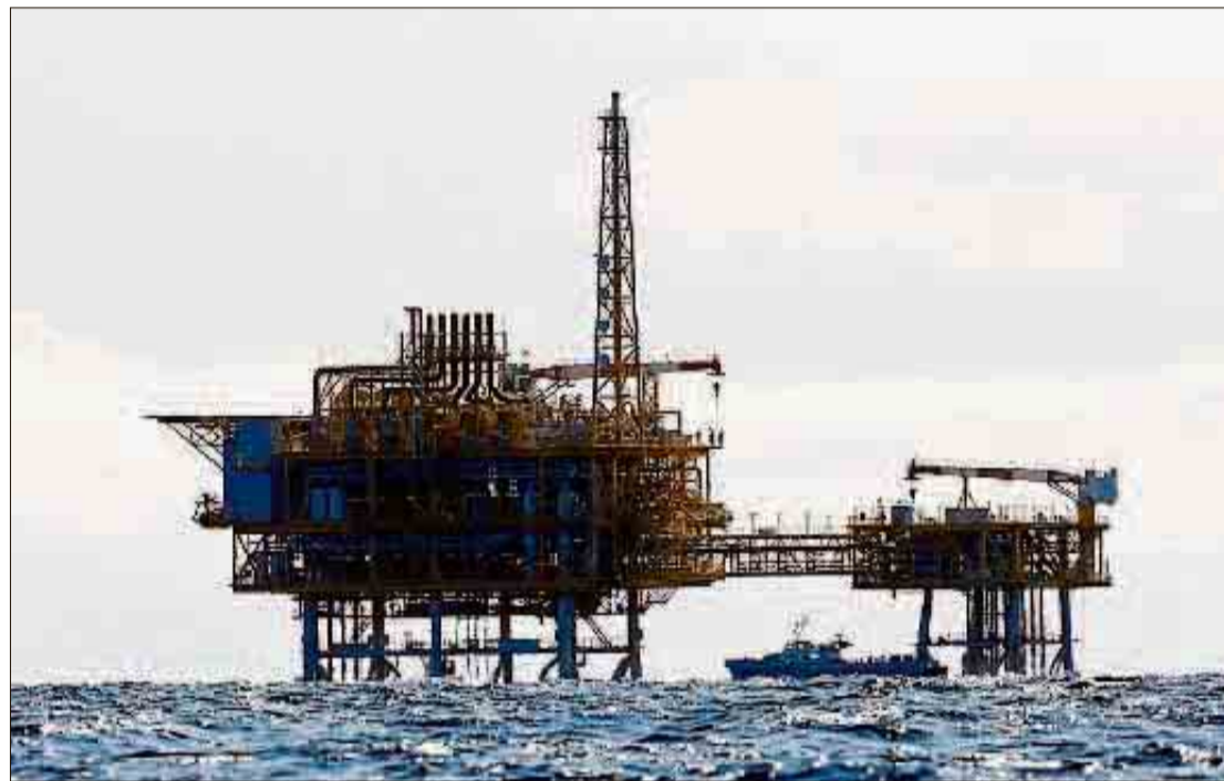
El almacén Castor se sitúa a 21 kilómetros de Vinaròs y a 1.700 metros bajo el mar. LEVANTE-EMV
