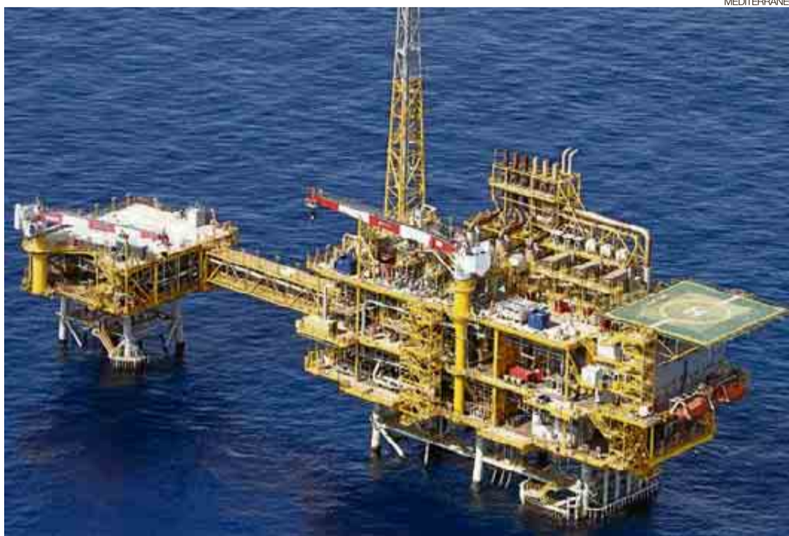
► La construcción de la planta del proyecto Castor supuso una inversión de 1.700 millones de euros.
