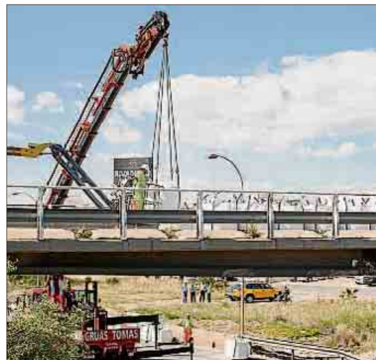
Prueba de carga en el puente del «scalextric». LEVANTE-EMV
