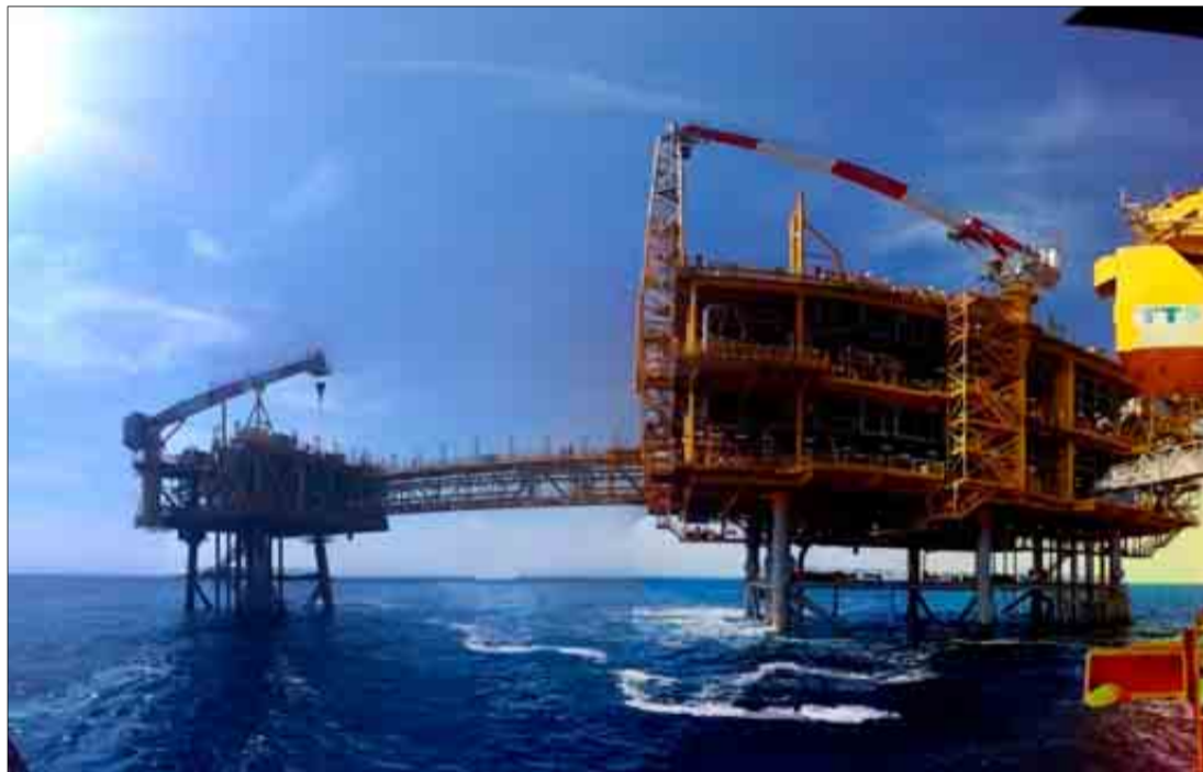
Vista general de la planta marina del proyecto Castor de Vinaròs. / EL MUNDO
