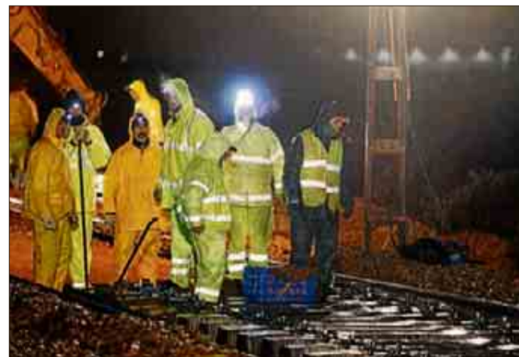
Obras del tercer raíl en el tramo de Nules. LEVANTE-EMV
