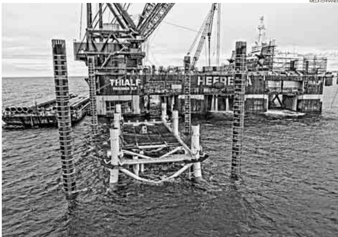
► Un momento de la construcción de la plataforma marina del almacén de gas Castor, frente a Vinaròs.
