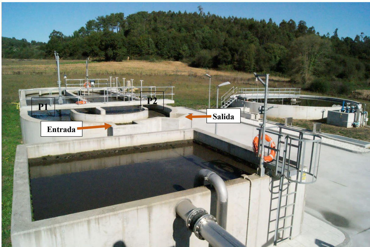
Figura 5.13.- Vista del canal desde aguas arriba. En primer plano, el tanque prismático anaerobio. Se indican los puntos 1 y 2 (P1 y P2) de muestreo del canal, desde el puente.
