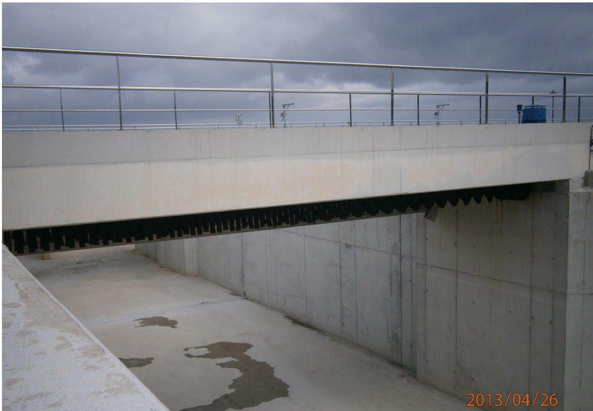
Figura 2.9. Rotores de aireación y agitación con forma de peine (EDAR de Ares).
