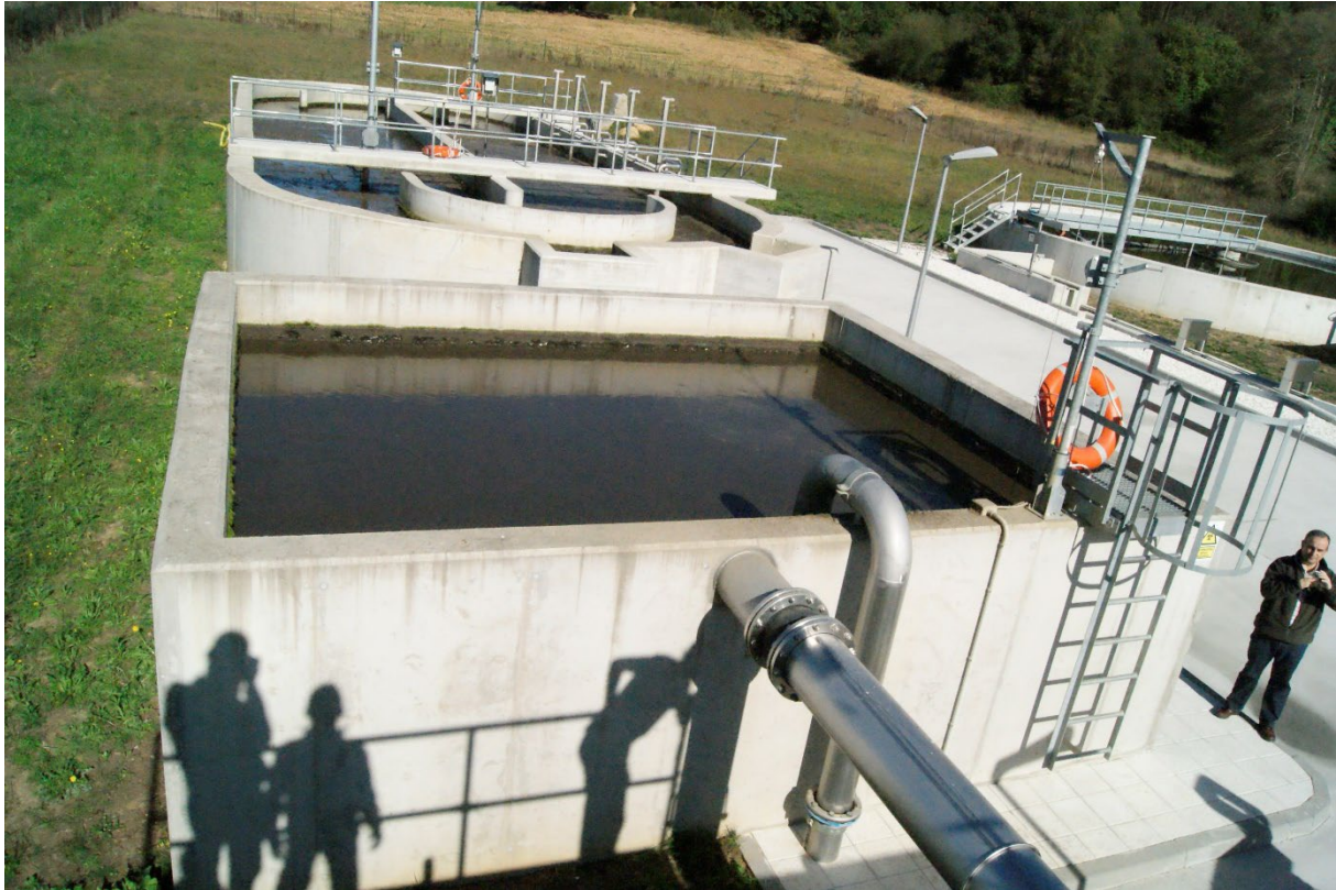
Figura 4.8.- Imagen en primer plano del tanque anaerobio (EDAR de Carral).
