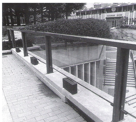
Fig. 32 e 33 – A escadaria deste jardim sobre cobertura em Los Angeles é acompanhada por escadas rolantes (em cima); Barreira de protecção de 106,7cm de altura é uma norma de segurança para jardins sobre cobertura. (em baixo). Fonte: Osmundson, 1999, pp.149-151.
