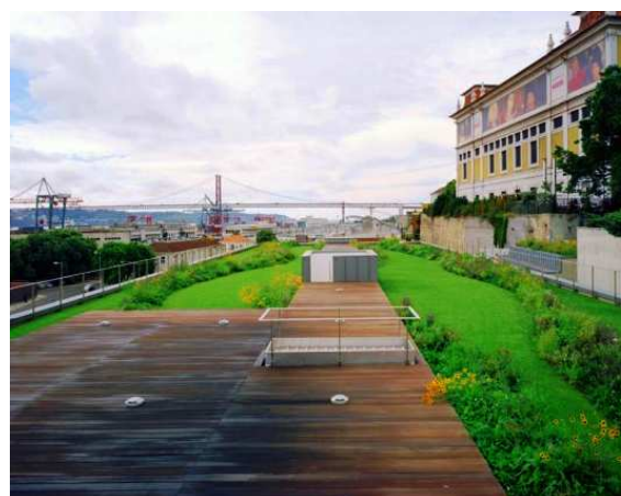
Fig. 27 – Cobertura da sede do Banco Mais na Avenida 24 de Julho em Lisboa. Fonte: < http://www.byrnearqu.com >.
