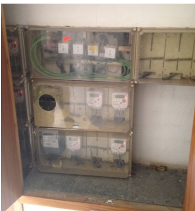
Ilustración 40. Contadores de luz
