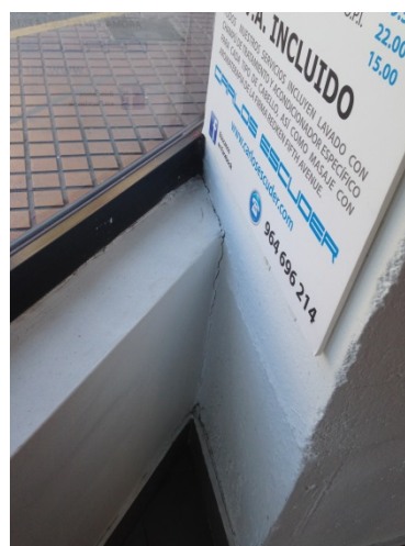
Ilustración 136. Deterioro junta
