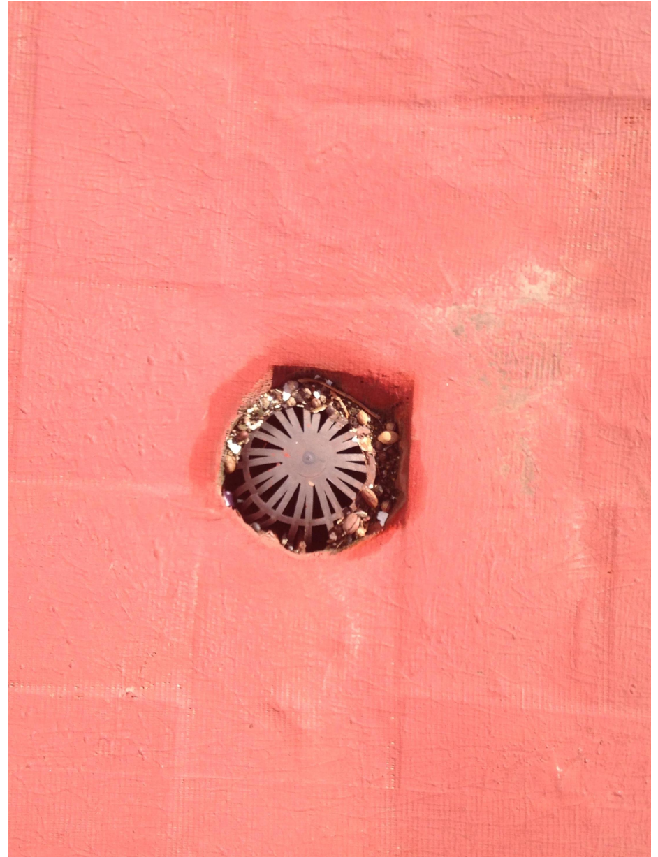
Cubierta 1. Recogida de Aguas [Ref. CU004]
