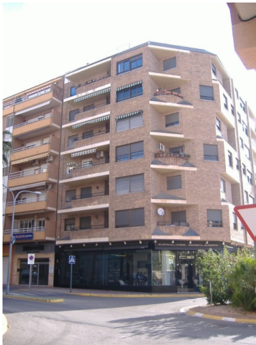
Ilustración 5. Fachada Oeste, Fachada Suroeste
