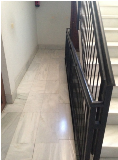
Ilustración 34. Pasillo zona común
