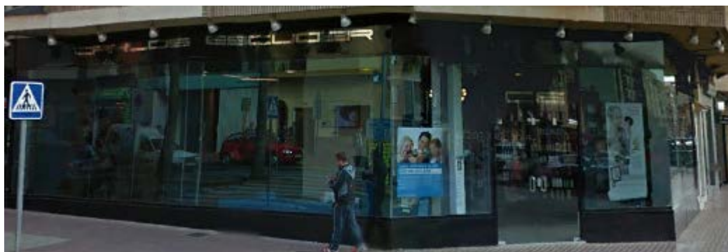
Ilustración 94. Fachada planta baja, F2b
