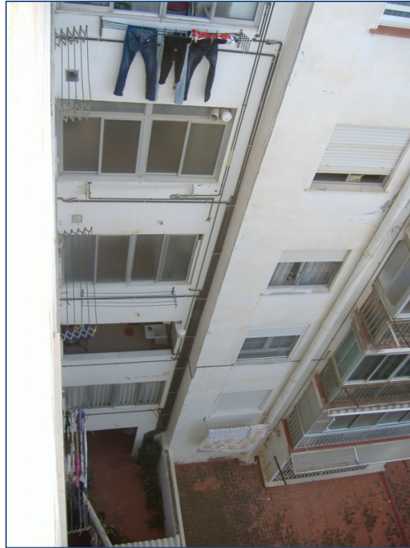
Ilustración 103. Fachada del patio de luces, F4
