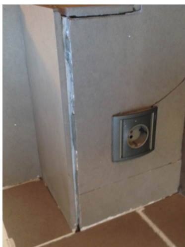
Ilustración 134. Desprendimiento alicatado
