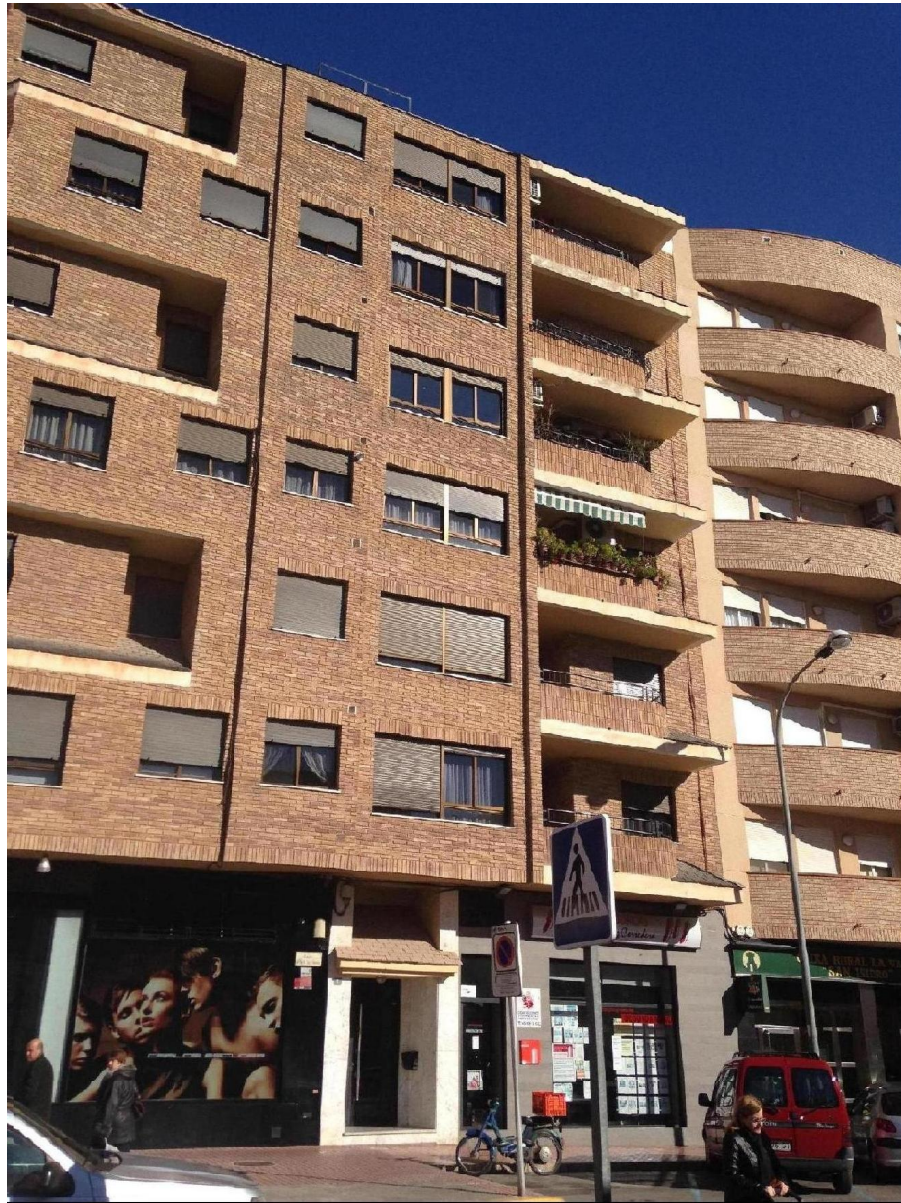
Fotografía de la fachada principal
