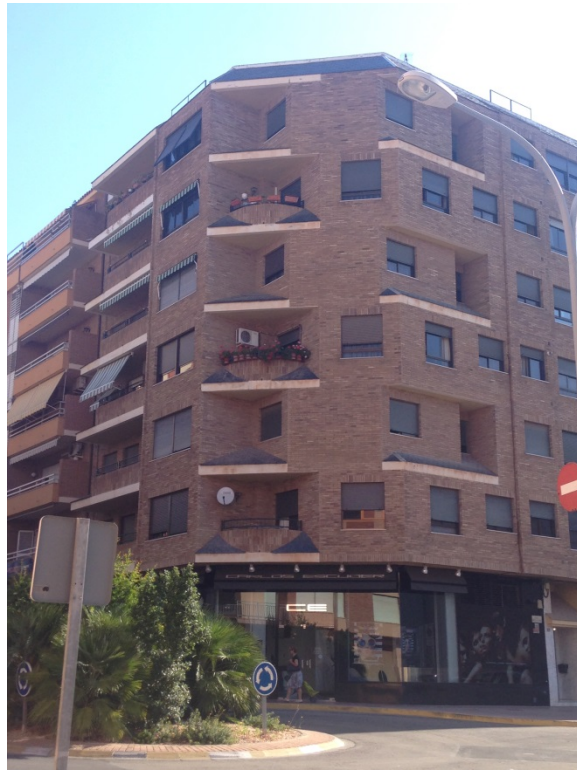
Ilustración 91. Fachada suroeste, F2
