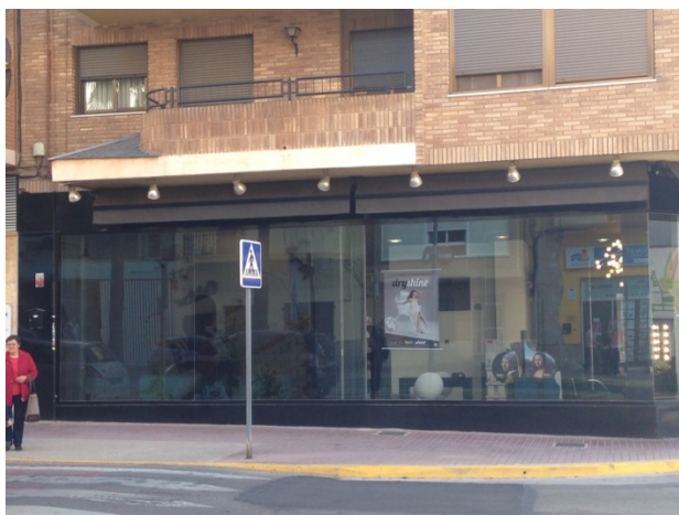
Ilustración 100. Fachada planta baja, F3b
