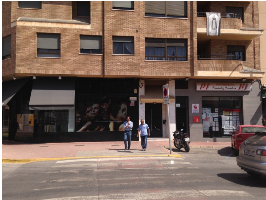
Ilustración 88. Fachada planta baja, F1b
