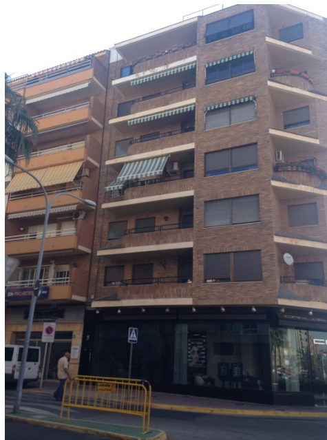
Ilustración 97. Fachada oeste, F3
