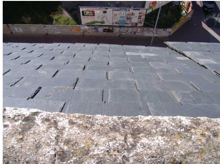
Ilustración 126. Cubierta inclinada del edificio
