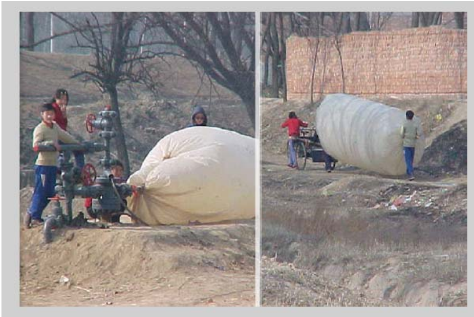
Almacenamiento Subterráneo de Gas Natural
