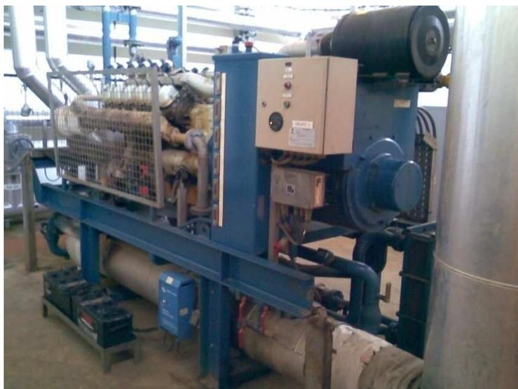
**Figura 2.4** – Grupo de co-geração para a produção de energia eléctrica no sub-sistema de Beirolas
