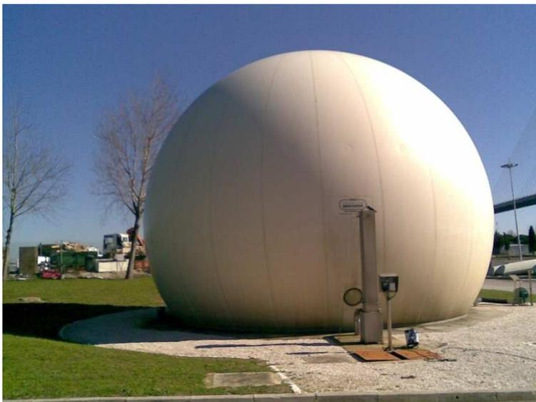
**Figura 2.3** – Gasómetros para armazenamento do biogás.no sub-sistema de Beirolas
