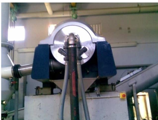
**Figura 3.4** – Centrifugadora para a desidratação da lama no sub-sistema de Beirolas
