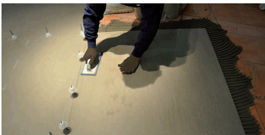
Imagen 45. Ejercer presión sobre la baldosa con la llana
