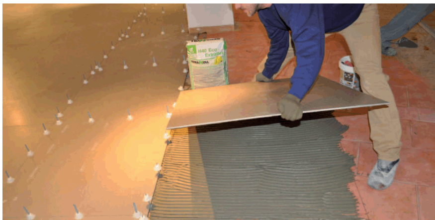
Imagen 44. Colocación de las baldosas con crucetas
