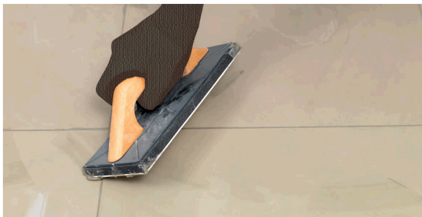
Imagen 46. Rejuntado de las juntas
