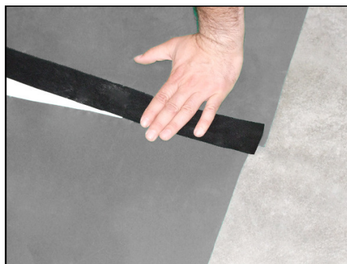
Imagen 25. Colocación lámina viscoelástica
