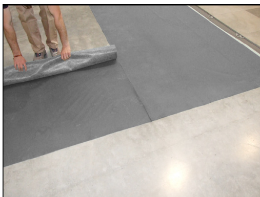
Imagen 25. Colocación lámina viscoelástica
