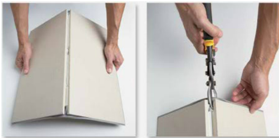
Imagen 38. Cortes placa Pret-a-porter
