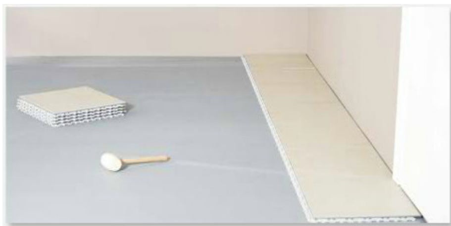
Imagen 37. Colocación placas Pret-a-porter
