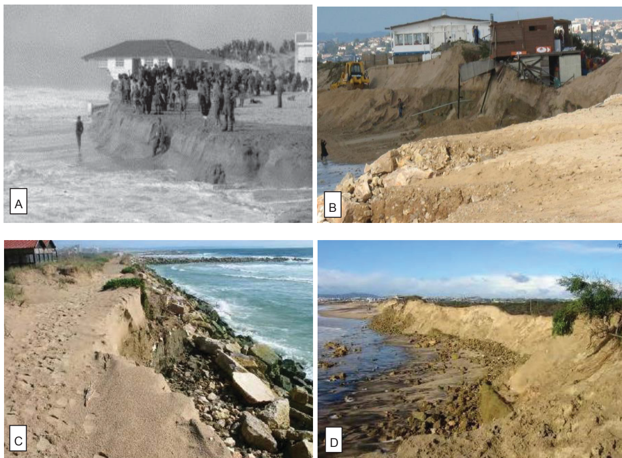
Figura 10 – Aspectos da erosão dunar: Galgamentos marinhos na Costa da Caparica nos anos 60 (A) e 2007 (B; CMA 2007), erosão da base das dunas observada em S. João e da destruição do paredão da Costa da Caparica em 2003 (C) e 2006 (D) (Velooso-Gomes, et al , 2007).
