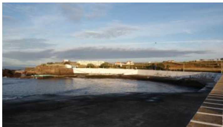
Figura 15. Fotografia da Zona Balnear do Negrilo
