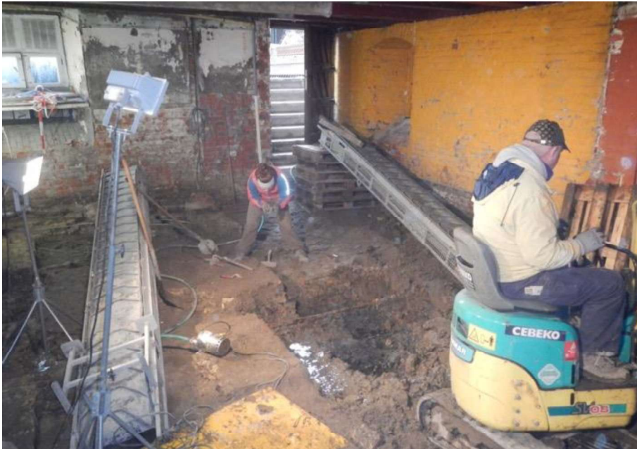
Figuur 5: Moeilijke werkomstandigheden in WP2 tijdens het onderzoek van de zone van de liftput (© agentschap Onroerend Erfgoed).
