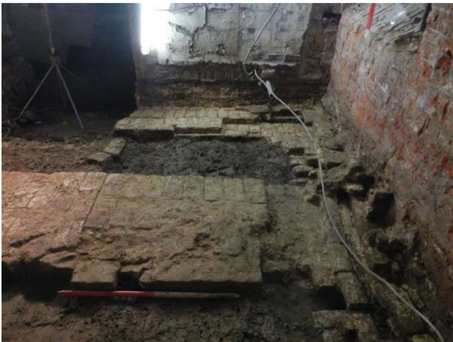
Figuur 28: WP2 met centraal de massieve 13de-eeuwse muur van het oorspronkelijke Vleeshuis en rechts en op de achtergrond de vermoedelijk 16de-eeuwse bakstenen vloeren waar in het zuiden ook een klein afwateringskanaaltje is ingewerkt (© agentschap Onroerend Erfgoed).
