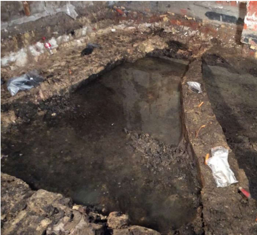
Figuur 4: Wateroverlast in het zuidoosten van de eerste kelder (WP1) (© agentschap Onroerend Erfgoed).
