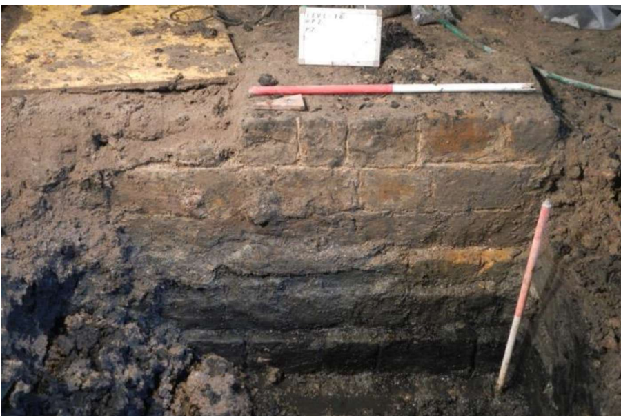
Figuur 18: Paramentzijde van de massieve muur met blokken en lagen afgewisseld in grijze Noord-Franse Bethunesteen en bruine ijzerzandsteen. Onderaan de jalon bevond zich een insprong in oranje en gele bakstenen van formaat 27,5 x 13 x 6,5 cm (© agentschap Onroerend Erfgoed).
