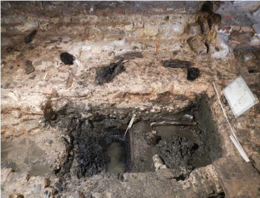
Figuur 29: Zicht op de verdieping langs de westzijde van het massief, dat nog 50 cm dieper ging en gevormd werd door een zeer harde cementachtige constructie van grijze mortel, baksteen- en natuursteenbrokken (© agentschap Onroerend Erfgoed).
