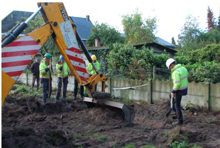
Figuur 8: De aanleg van vlak 1 op 2 oktober 2019 (© agentschap Onroerend Erfgoed).
