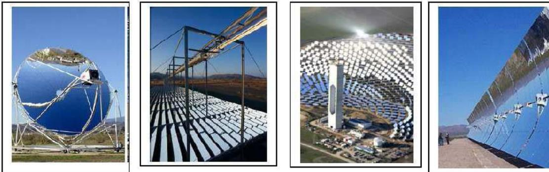
**Ilustración 1 - De izquierda a derecha, un disco parabólico, un concentrador lineal tipo Fresnel, un sistema de receptor central y un colector cilindro parabólico.**
