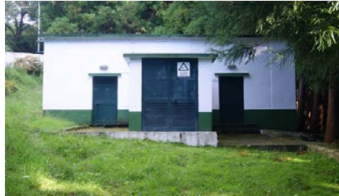
Figura 4 - Estação de Tratamento de Água (ETA) da Nasce Água.
