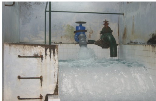
Figura V: Entrada de água na camara de arejamento provinda da nascente.
