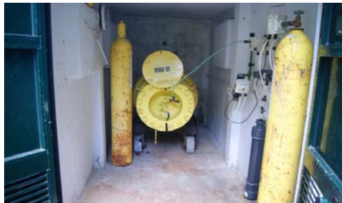
Figura 5 - Tambor de cloro gasoso de 600 kg, garrafa de reserva de cloro e clorómetro.
