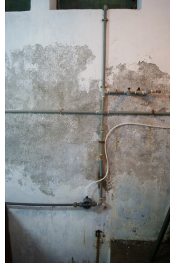
Figura III: Junção do cloro gasoso na tubagem para posterior entrada na camara de contacto.
