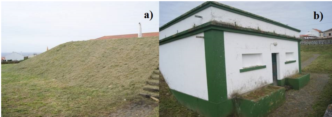
Figura 7 - Reservatório da cidade: a) célula que abastece o caso de estudo e b) Câmara de manobras.
