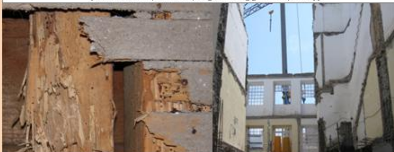
FIGURAS 2 e 3 – Danos causados pela C. brevis numa habitação em Angra do Heroísmo (Guerreiro et. al. , 2010)
