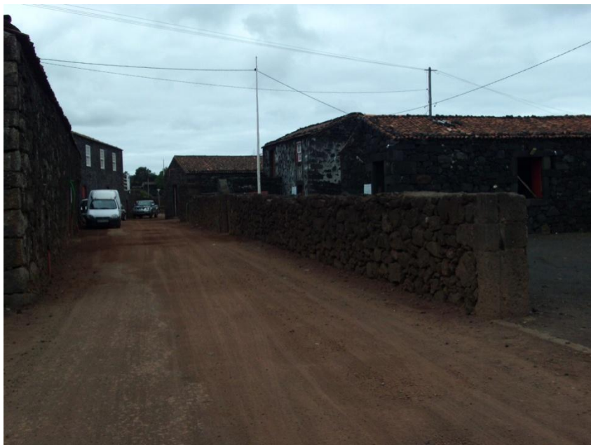
Fig.27 – Alambique integrado num complexo de construções.
