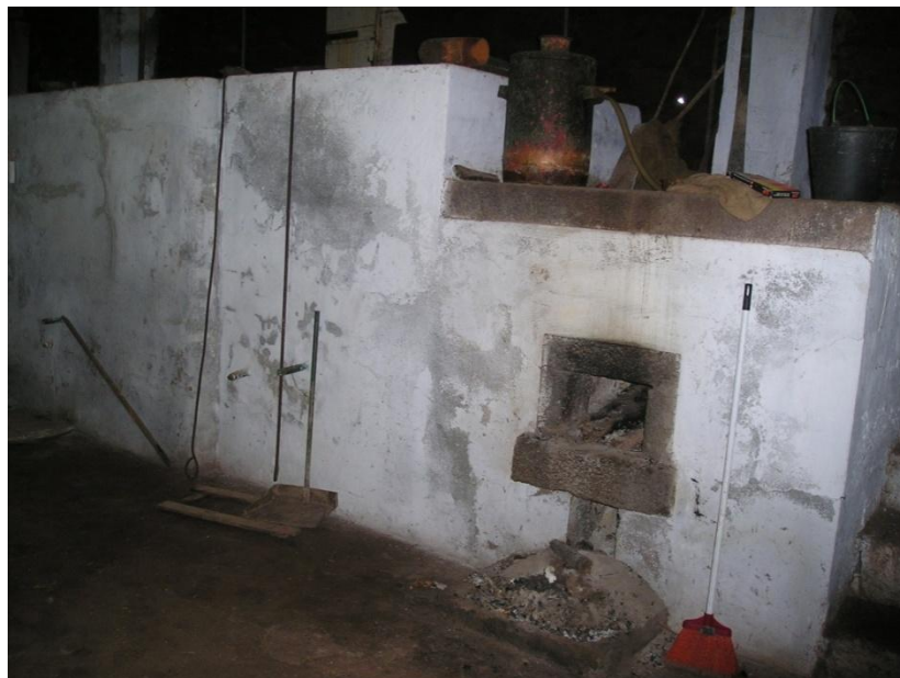
Fig.35 – Fornalha do alambique. Cachorro - Bandeiras
