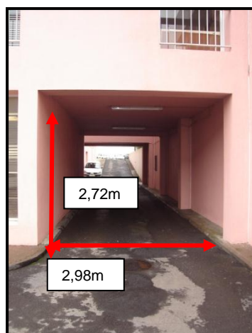
Figura 6 - Túnel de acesso à fachada principal pelo portão de cima
