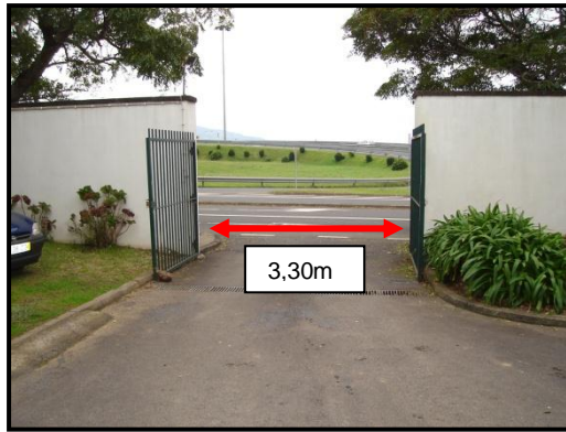
Figura 4 - Portão de acesso viaturas de socorro
