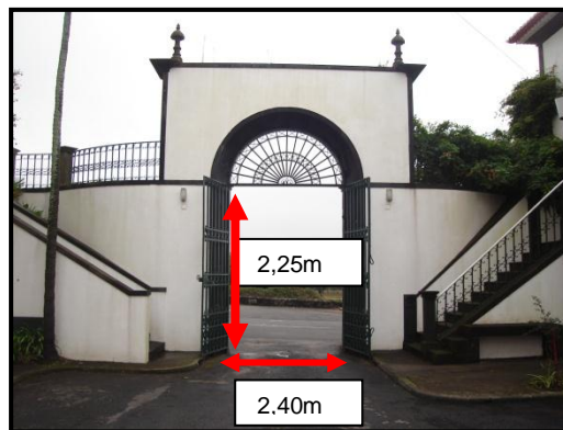
Figura 5 - Portão de acesso principal
