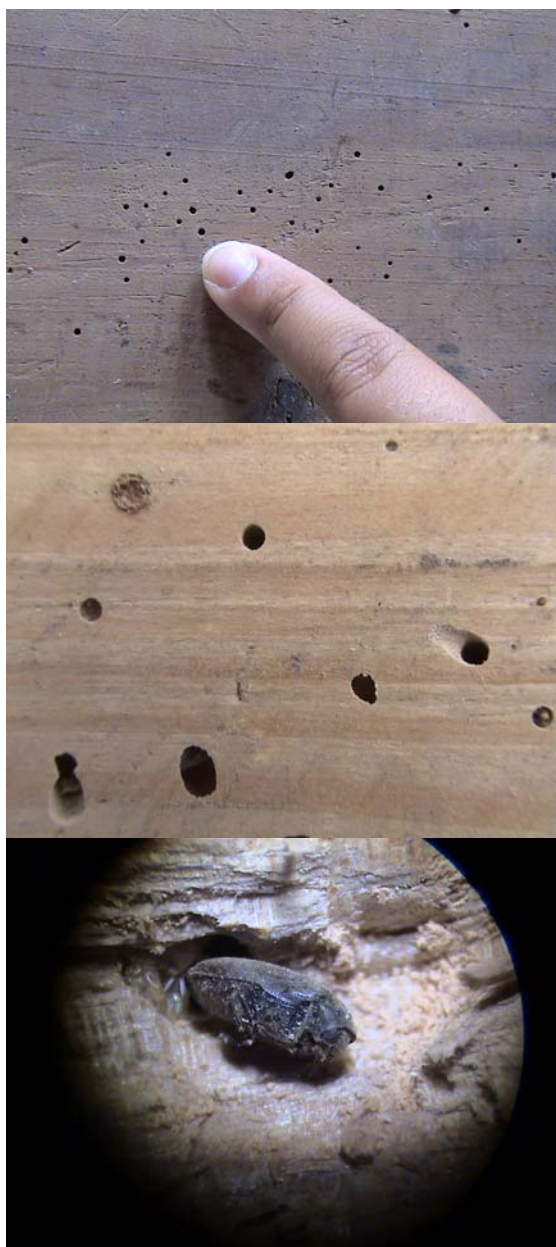
Figura 10. Os buracos de emergência dos adultos [(a) e (b)] e de caruncho (c) servem de zonas de entrada para os alados de C. brevis .
