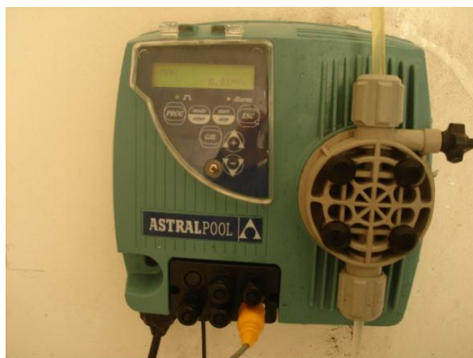
Figura 4.9 - Equipamento responsável pelo sistema automático de adição do desinfetante.
