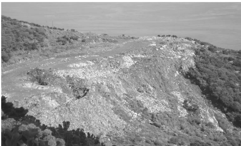
Figura 2 - Lixeira a céu aberto no cimo de uma falésia junto à costa, com uma erosão bem visível do terreno devido ao seu declive acentuado.
