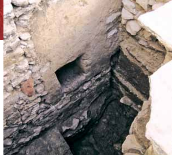
Ferrarias del Rey . Vista da parede do antigo edifício das Ferrarias, correspondente ao sector exteriormente ocupado por uma porta, depois fechada.
