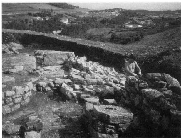
Fig. 9 - Pormenor dos trabalhos de consolidação e restauro realizados nas estruturas arqueológicas entre 1988 e 1993.
