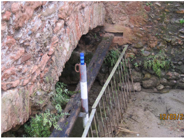
Figura 3. Detalle de un medidor de agua
