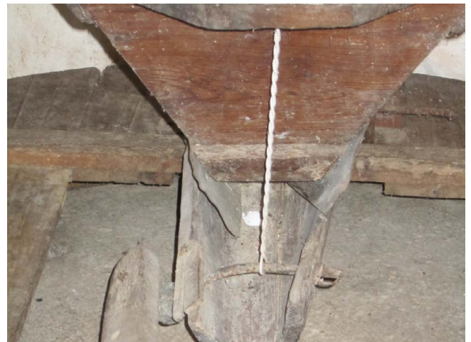
Figura 14. Detalle salida de la tolva
