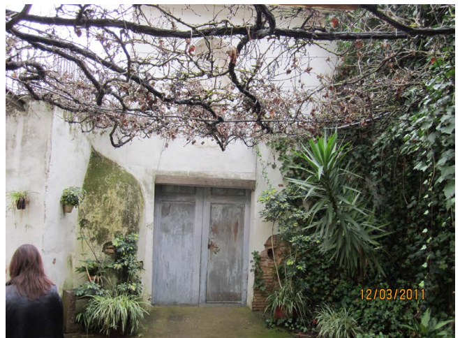
Figura 8. Molino Paquero, fachada principal
