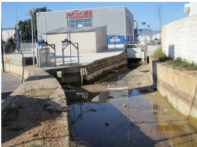
Figura 7. Bifurcación de la séquia Major en dos acequias: Sobirana y Jussana
