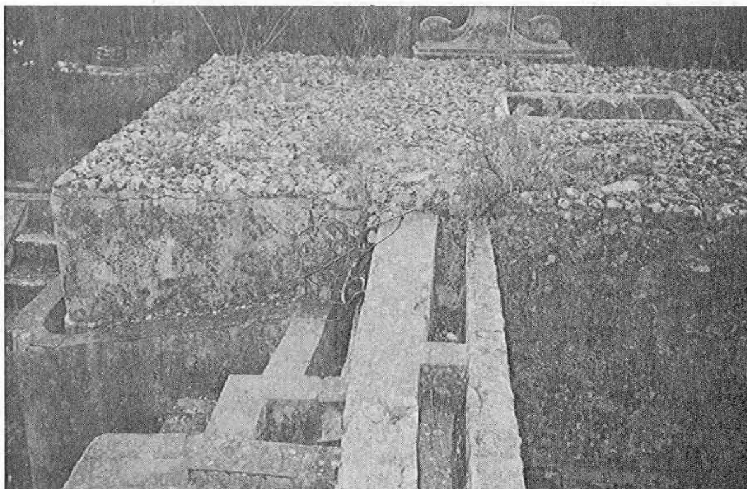
Fig. 20 — Bom Jesus. Trecho final do aqueduto, câmara de distribuição de água e trecho final da caleira de alimentação do jardim
