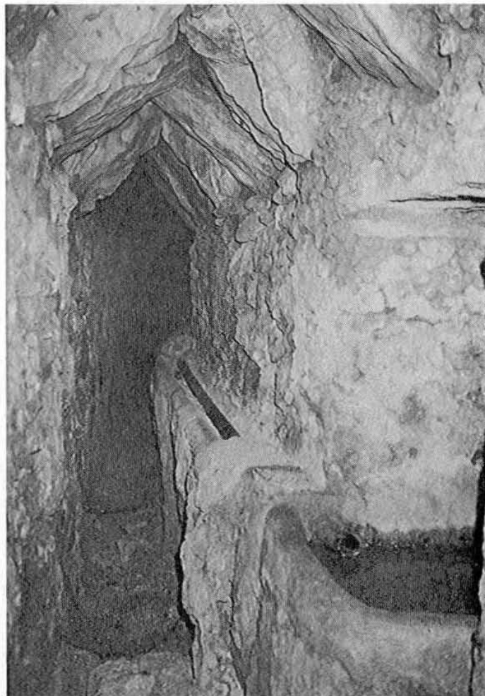
Fig. 11 — Mina 3. Vista para montante, mostrando a caleira sobre parapeito e a câmara de decantação
