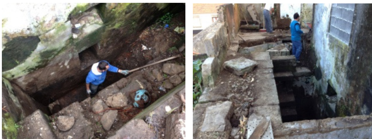
Figura 59 – Trabalhos de remoção de entulho no fosso da roda do moinho da Rua Frei Diogo das Chagas, n. os 11 e 13, Nossa Senhora da Conceição. Fotografia do Gabinete de Arquitetura LBa. Ano de 2013.
