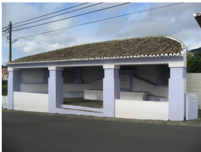
Figura 46 – Chafariz do Reguinho, São Bento. Fotografia do autor. Ano de 2010.
