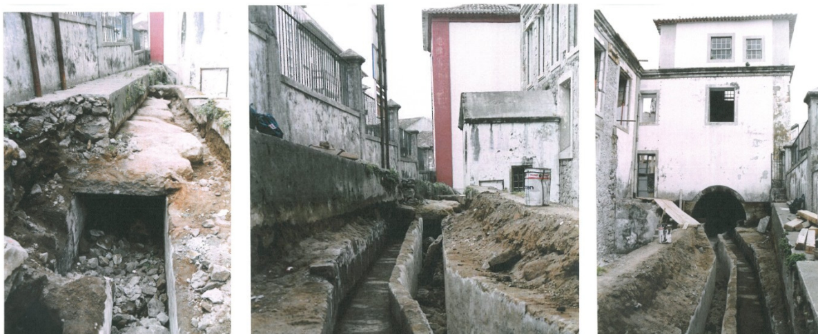
Figuras 47, 48 e 49 – Troço da Levada da Ribeira dos Moinhos – Convento de São Francisco –, Nossa Senhora da Conceição. Fotografias obtidas no âmbito do acompanhamento da obra de recuperação do Convento de São Francisco. Fotografias de autor desconhecido. Década de 90.
