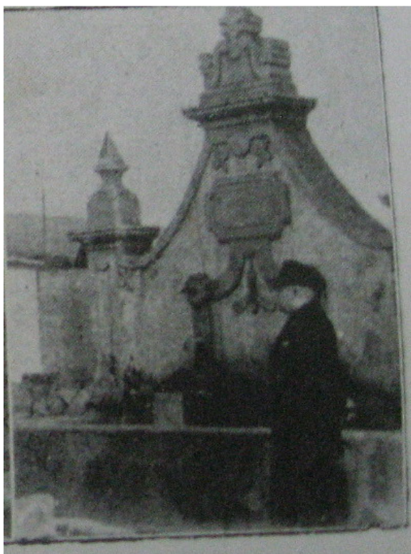
Figura 16 – Chafariz do Largo do Desterro, Nossa Senhora da Conceição, destruído no pós-sismo de 1980. Autor desconhecido.
