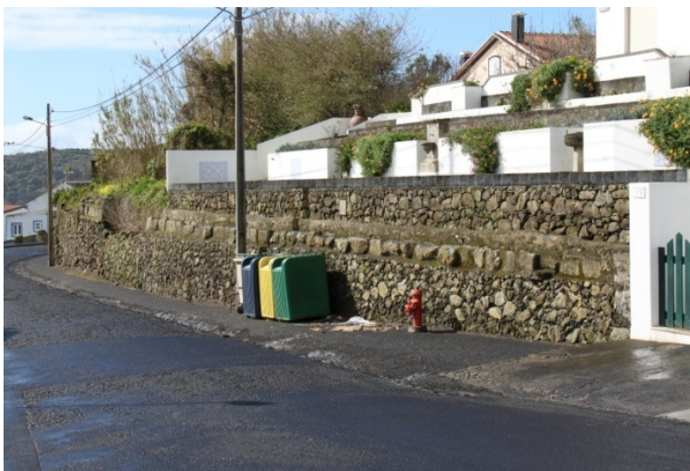
Figura 51 – Troço da levada da Ribeira dos Moinhos, Rua Ribeira dos Moinhos, Santa Luzia. Fotografia de Paulo José Mendes Barcelos. Ano de 2011.
