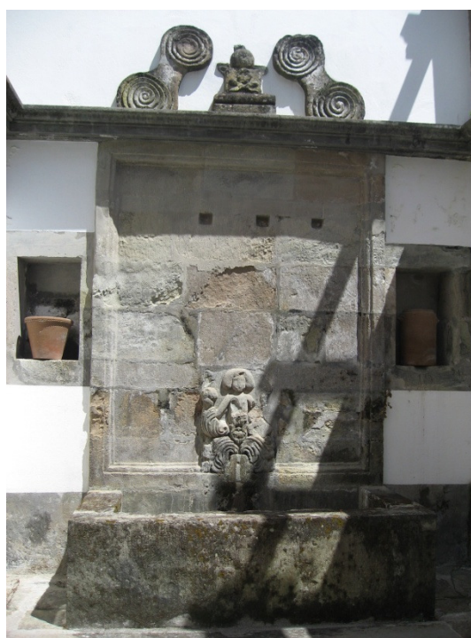
Figura 35 – Chafariz da Rua Direita, n.º 74, Sé. Após reabilitação. Fotografia do autor. Ano de 2010.
