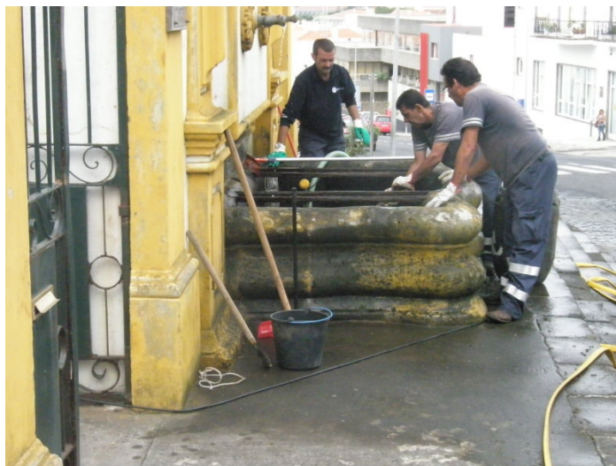
Figura 52 – Chafariz do Alto das Covas, Alto das Covas, Sé. Intervenção camarária na limpeza. Fotografia de José Henrique Pereira. Ano de 2011.
