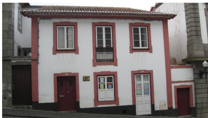
Figura 58 – Casa com moinho da Ladeira de São Francisco, n. os 2 e 4, Nossa Senhora da Conceição. Fotografia do autor. Ano de 2011.
