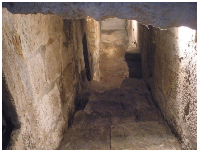
Figura 63 – Troço da levada restaurada. Rua da Garoupinha, n.ºs 31 e 33, Nossa Senhora da Conceição. Fotografia do autor. Ano de 2012.
