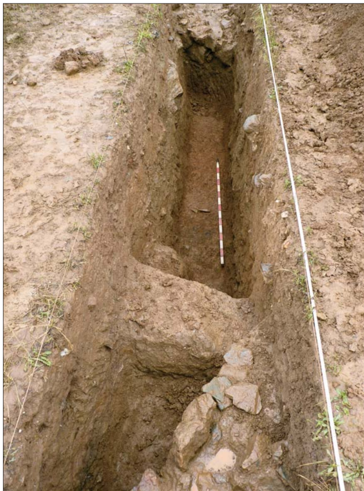
FIG. 1 – Aspecto de um trecho da Sondagem 2 no Cabeço Redondo (2011), sendo visíveis, em primeiro plano, um muro de adobes e outro de pedra, perpendiculares.
