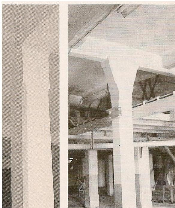
Foto 31 – Perspectiva do sistema estrutural da fábrica do Caramujo – pilares, vigas principais, vigas secundárias, lajes maciças, in FERREIRA, Carlos Antero – *Betão – A idade da descoberta*, p.130
