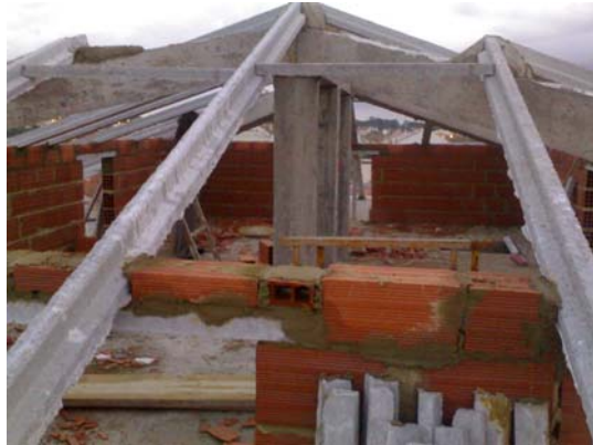
Figura 11- Imagem real de telhado com quatro águas
