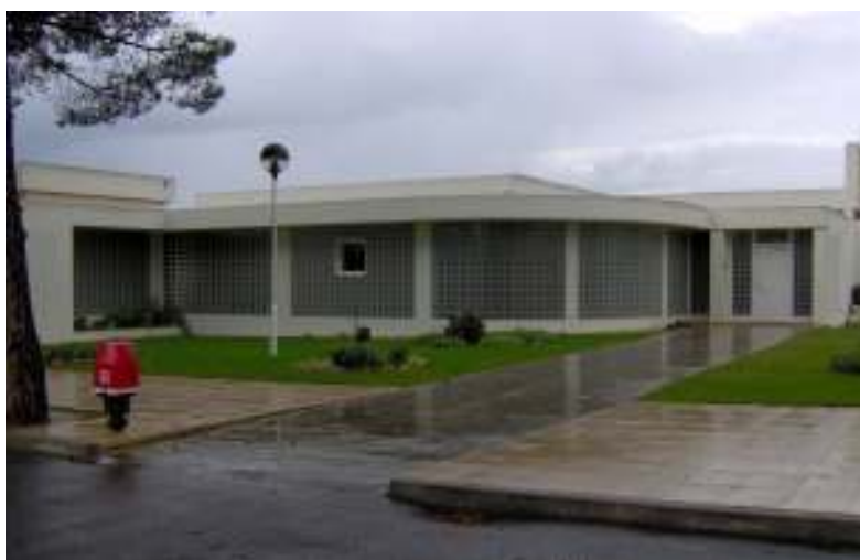
Foto nº 10 – Casa das Mães – entrada para o refeitório e RAVI
