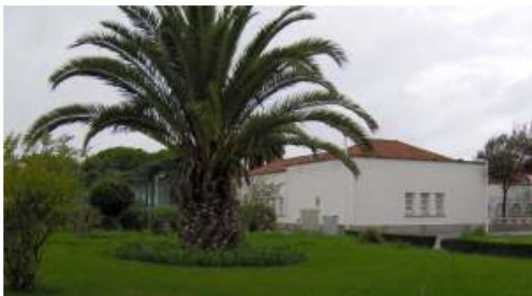
Foto nº 20 – Edifício da Creche
