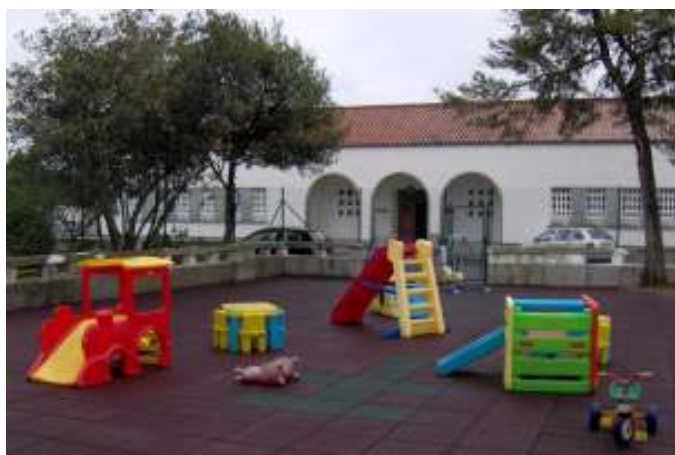
Foto n° 23 – Exterior da Creche
