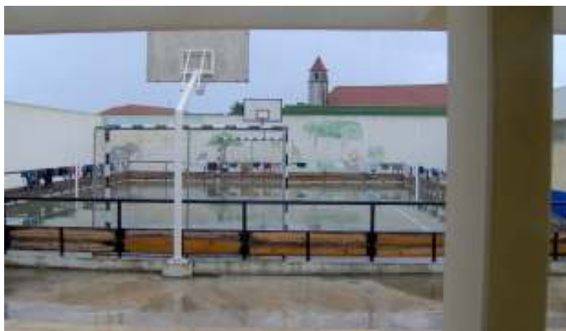
Foto nº 12 – Pátio Exterior da Casa das Mães
