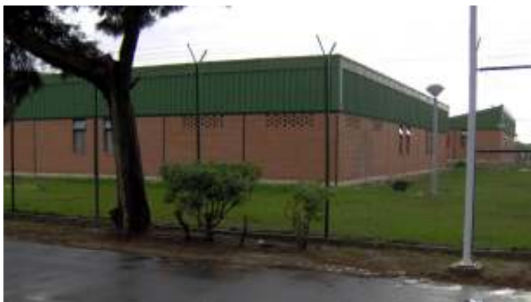
Foto nº 6 – Pavilhão de Regime Aberto
