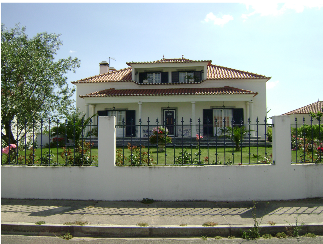
Fotografia nº 12 – Habitação de construção recente desta localidade
