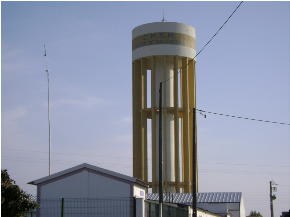
Fotografia nº 9 – Depósito de água no local do Estanqueiro
