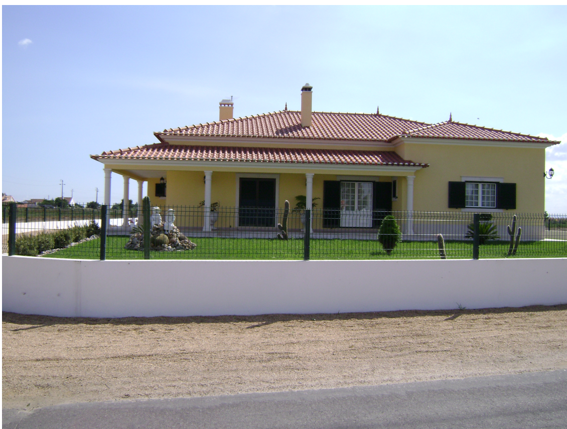
Fotografia nº 13 – Outro exemplar de habitação de construção recente nesta localidade
