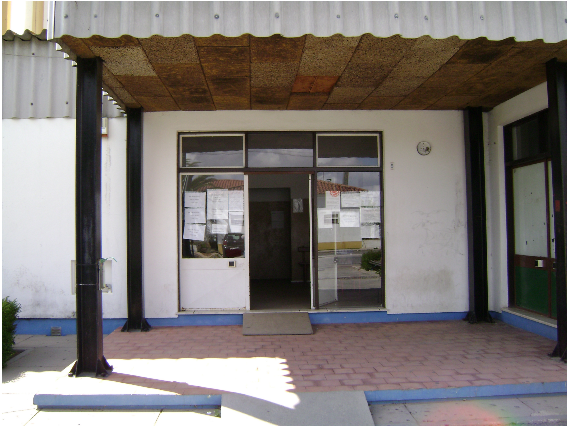
Fotografia nº 5 – Entrada da extensão do Centro de Saúde dos Foros de Salvaterra
