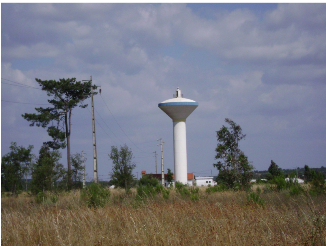
Fotografia nº 8 – Depósito de água no local da Várzea Fresca
