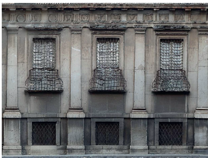
Fig. 10 – Ortofoto della facciata di palazzo Uggeri (Panchieri, 2015)
