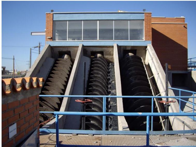
Figura 6: tornillo sin fin de salida de fangos de una EDAR
