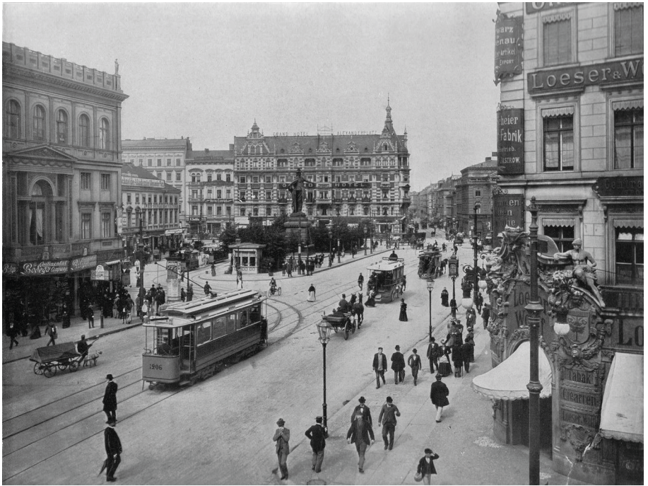
Abb. 1: Der Berliner Alexanderplatz, Berlin 1903. Die Fotografie verbildlicht die Transportmittel und Verkehrsteilnehmer um 1900. So koexistierten elektrische Straßenbahnen, Pferdekutschen und Hundefuhrwerke im Berliner Straßenverkehr. Quelle: J. Klaus Lemmer, Alexanderplatz – Ein Ort deutscher Geschichte , Stuttgart 1980, https://commons.wikimedia.org/wiki/File:Berlin_Alexanderplatz_1903.JPG [Stand: 10.4.2023] (© PD – Wikimedia Commons)
