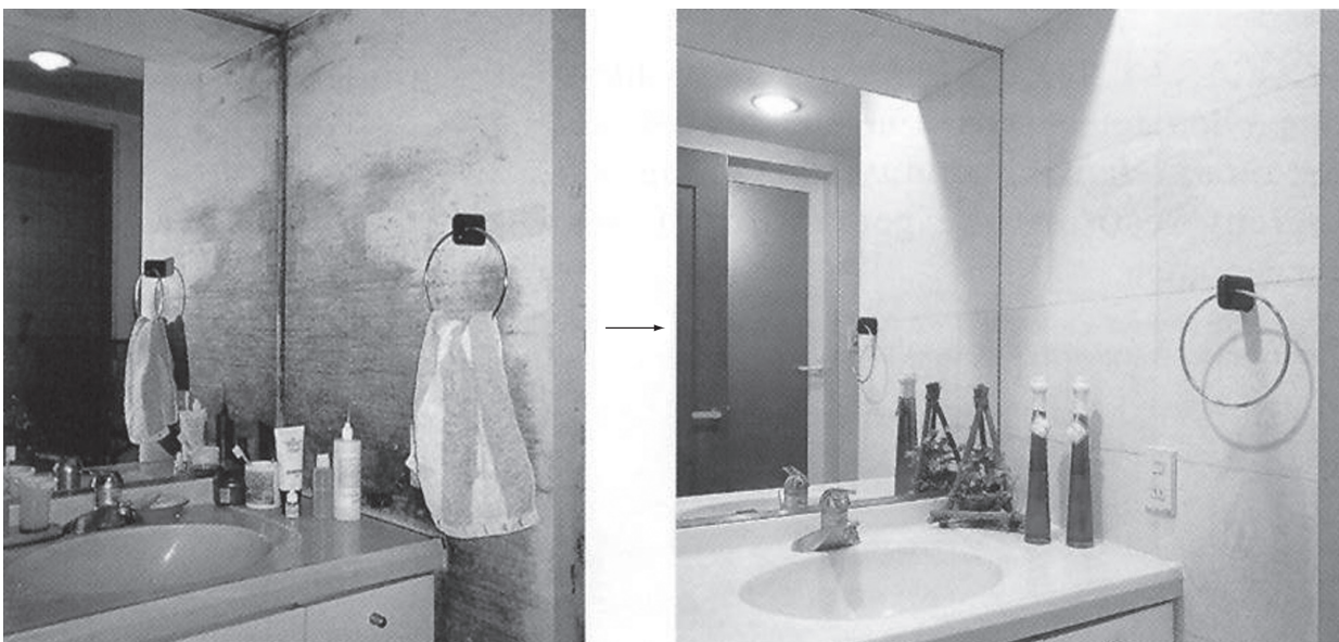
Figura 8. Influência do tipo de recobrimento sobre o desenvolvimento de microorganismos.
