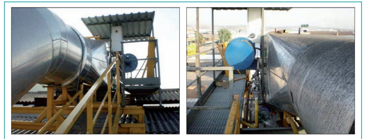
Figura 2. Vista general del sistema de acondicionamiento de la temperatura de entrada de la corriente a depurar.
