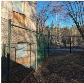
Figur 24. Höga staket omgärdar skolgården och delar av skolgården i två delar.
