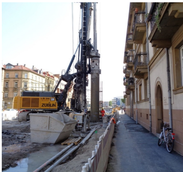
Bild 9 Bohrpfehlarbeiten im Bauabschnitt O3 zur Herstellung der Kragplatte
