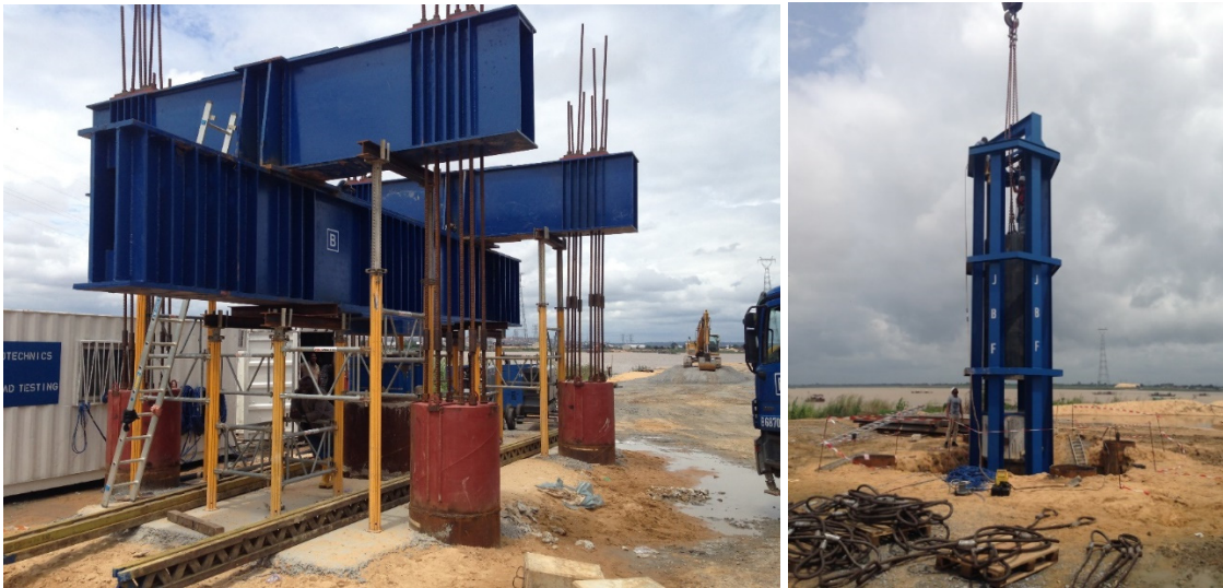
Bild 6 Statischer Pfahltest an gerammtem Stahlrohrpfahl (links) und dynamischer Pfahltest mit schwerem Fallgewicht (rechts)
