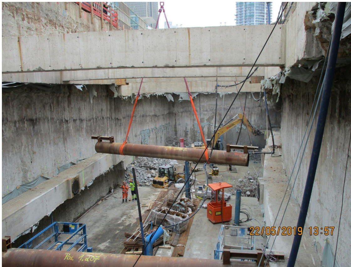
Bild 13 Rückbau der 2. Aussteifungsebene in der Startbaugrube
