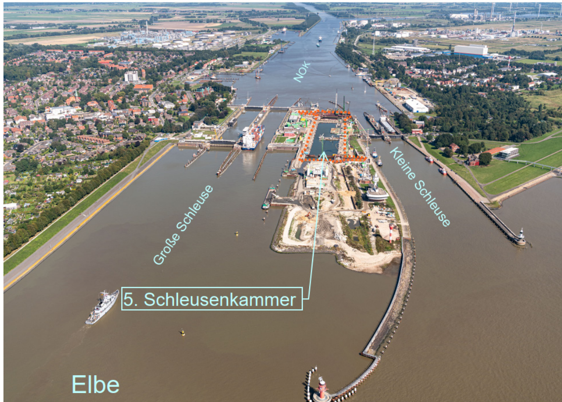
Bild 1 Luftbild der Schleuse Brunsbüttel mit Lage der 5. Schleusenkammer [Quelle: ARGE Neubau 5. SKB]
