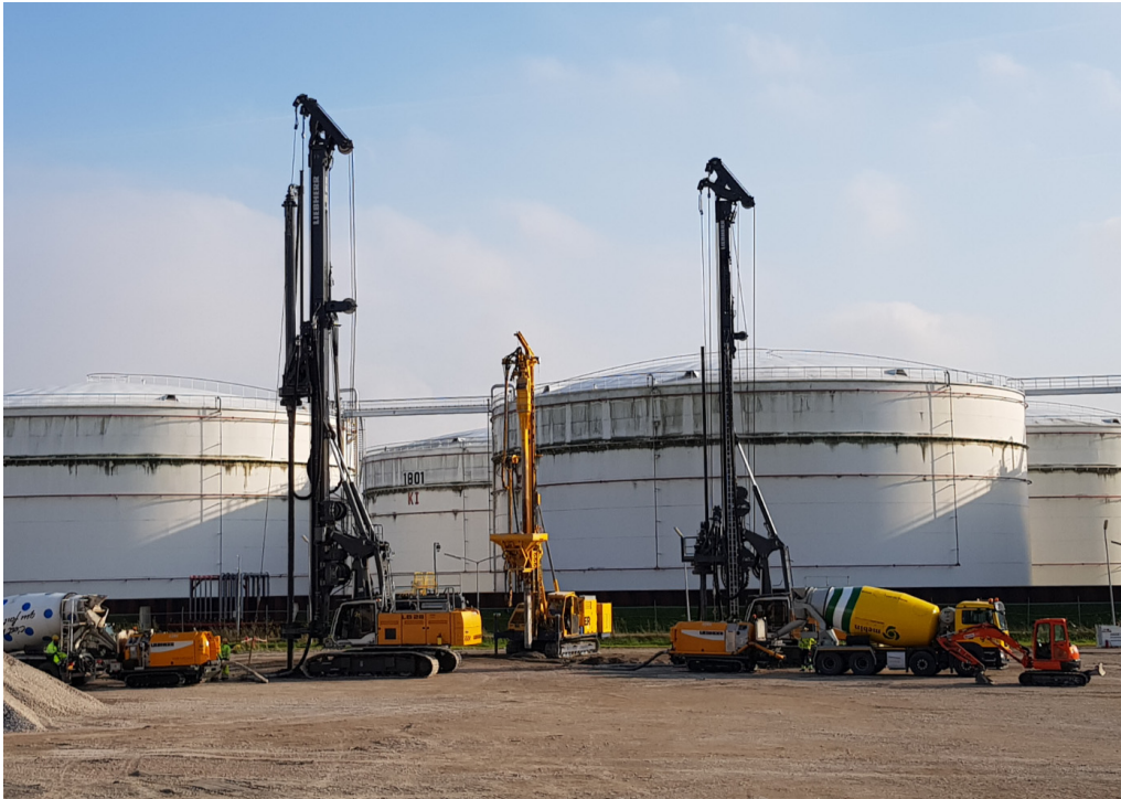
Bild 4 Produktion Hybridsäulen (CMM ® )
