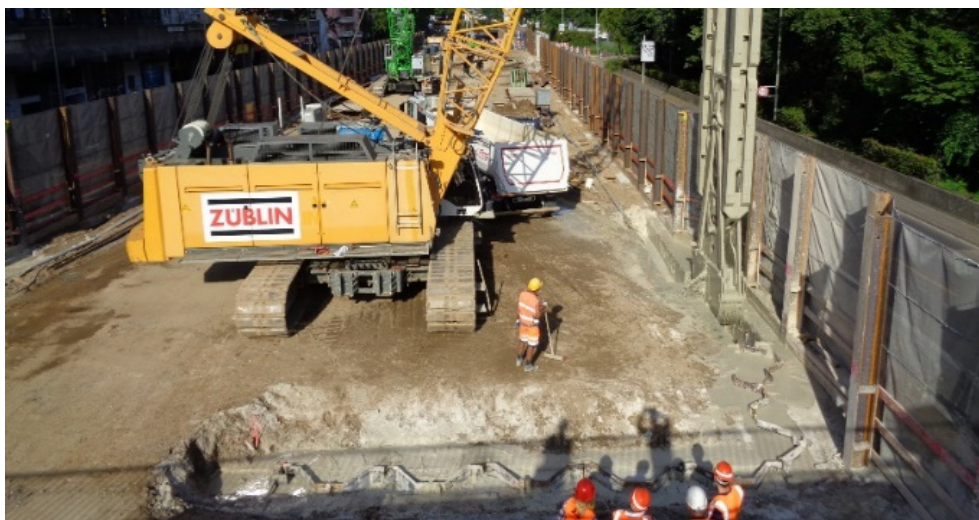
Bild 6 Schlitzarbeiten im Bauabschnitt W2
