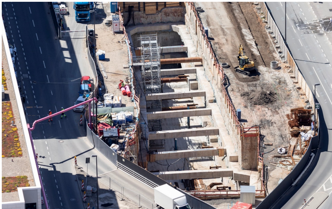
Bild 11 Startbaugrube, Bautenstand Mai 2019
