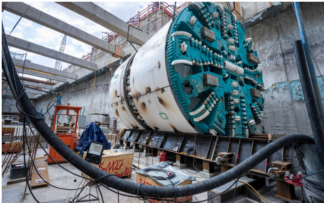
Bild 14 Schildmontage in der Startbaugrube
