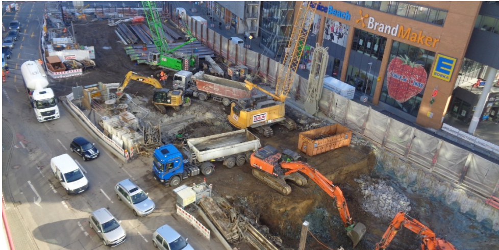
Bild 4 Seitenlage Verkehr im Baufeld O2 während den Bauarbeiten
