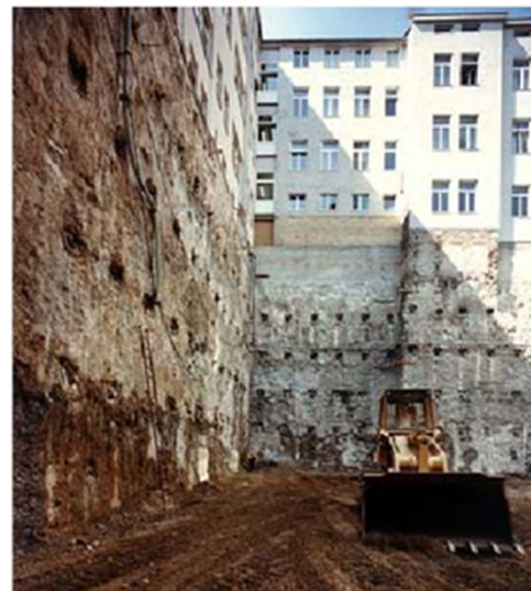
Bild 1 Mehrfach rückverankerter DSV-Unterfangungskörper in einer Baugrube
