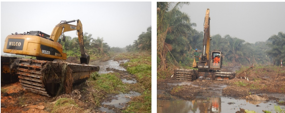
Bild 7 Einsatz von sogenannten swamp buggies zum bush clearing
