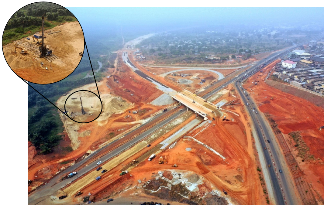
Bild 11 Autobahnkreuz „Owerri Interchange“ mit GEC-Herstellung im südwestlichen Kleeblatt
