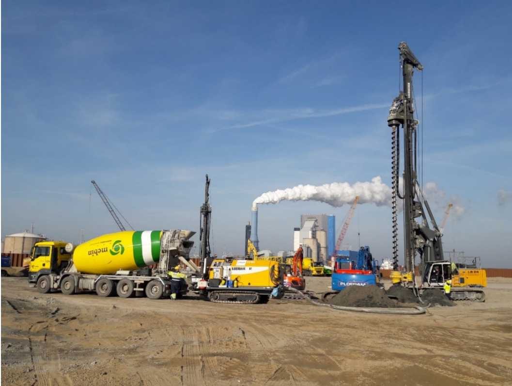
Bild 8 Produktion Rigid Inclusions
