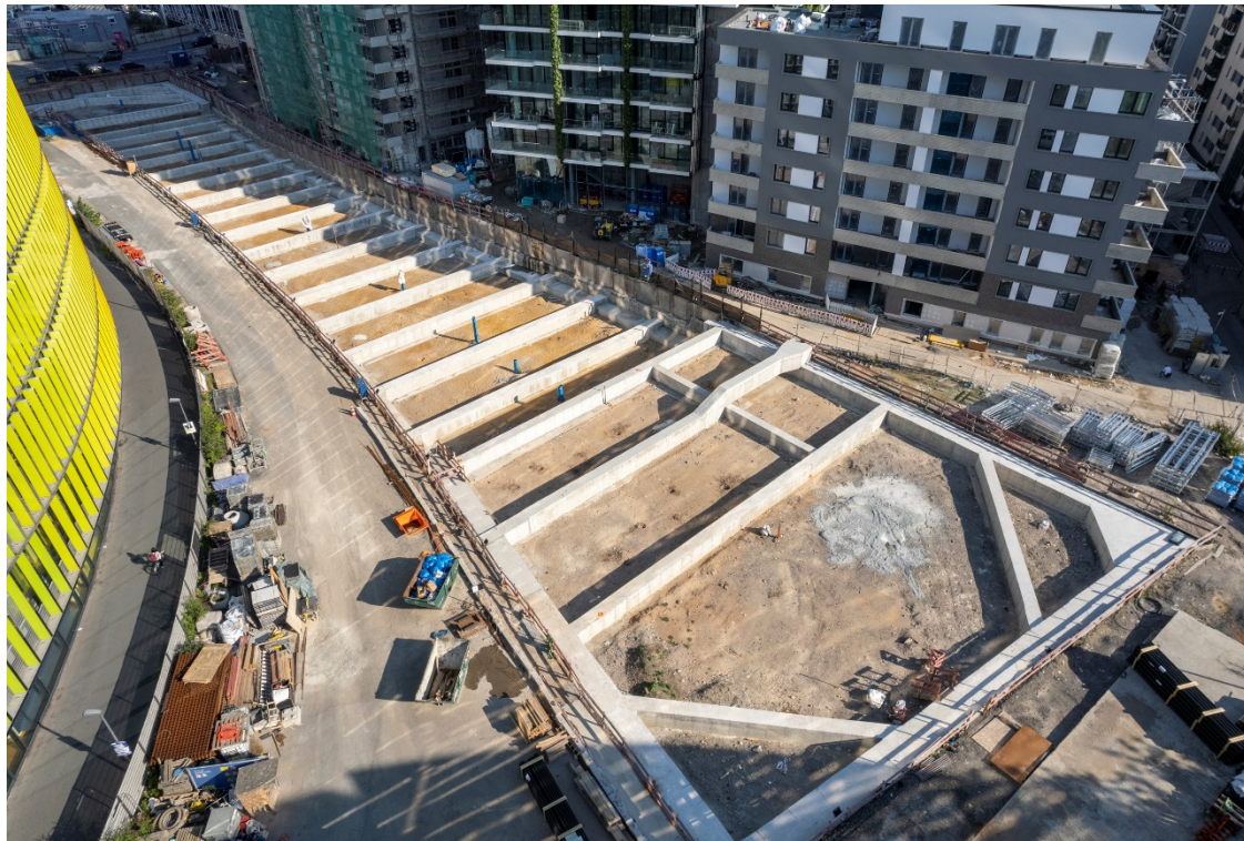
Bild 15 Station Güterplatz – 1. Steifenlage eingebaut
