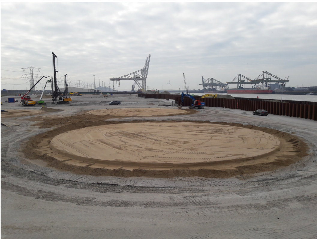
Bild 9 Fertig hergestellte Baugrundverbesserung für einen Tank
