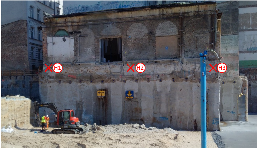
Bild 2 Mit DSV hergestellte Unterfangung einer Giebelwand mit Höhenmesspunkten H1, H2 und H3 (rote Kreuze) nach Aushub der Baugrube
