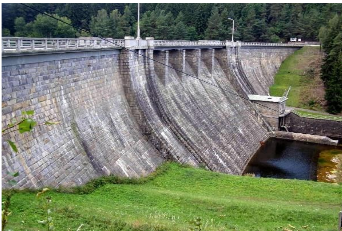
Obrázek 3: Husinecká přehrada - těleso hráze [16]
