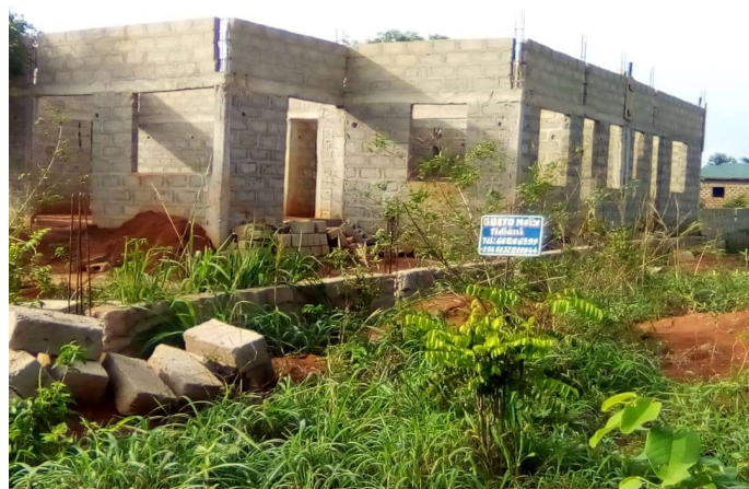
Photo 2: Domaine en chantier à Tori-Cada centre
