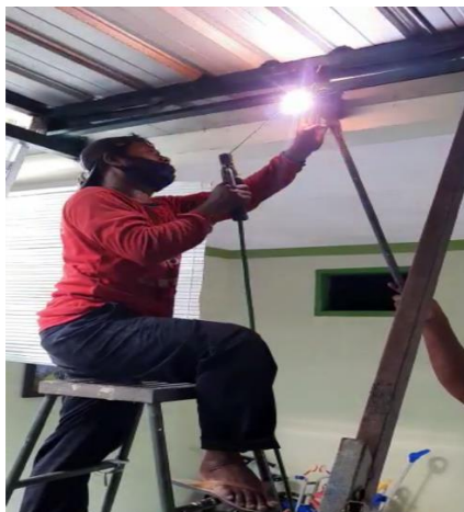
Gambar 4. Pekerja las dengan posisi overhead
