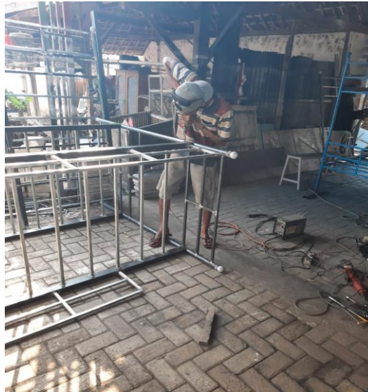
Gambar 6. Pekerja melakukan proses drilling
