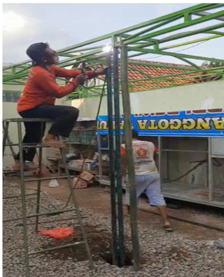
Gambar 2. Pekerja melakukan proses pengelasan
