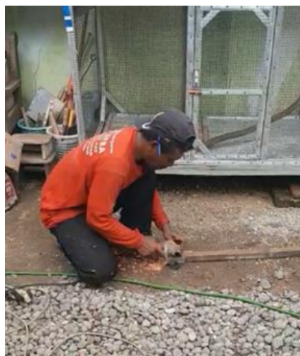
Gambar 3. Pekerja mengoperasikan mesin gerinda tangan
