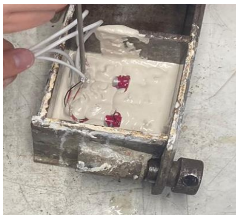
Рис. 12. Датчики в кондукторе внутри опалубочной формы (в процессе заливки)
