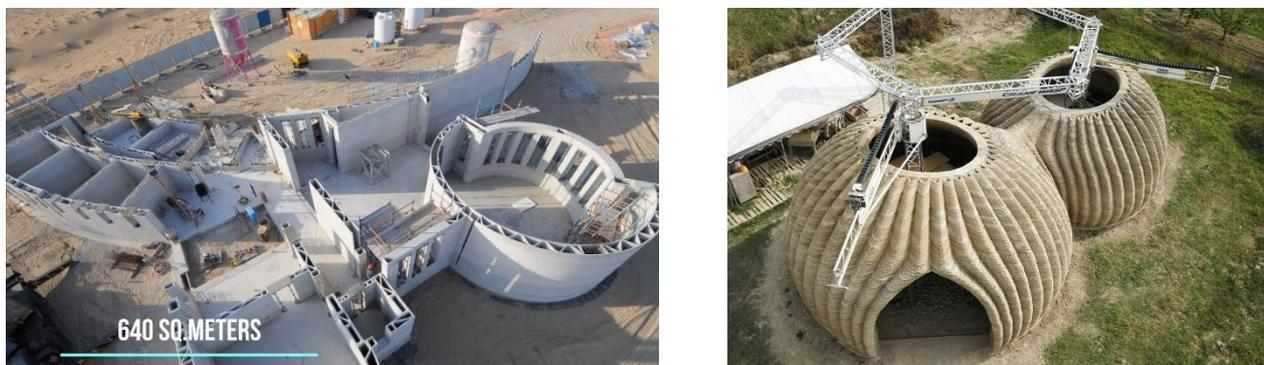
**Рис. 1.** Примеры возможностей 3DCP-технологии в реализации архитектурных форм и объемно-планировочных решений зданий (фото из общедоступных источников)
