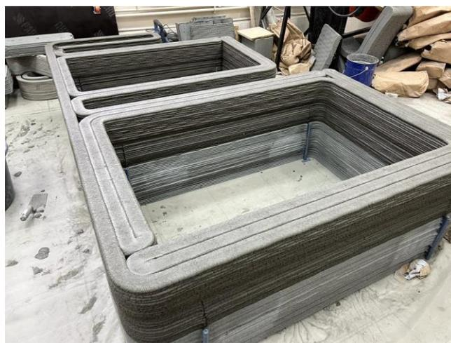
**Рис. 4.** Фрагмент конструкции, выполненный по технологии 3D-печати бетоном с трехрядным проходом печатающей головки
