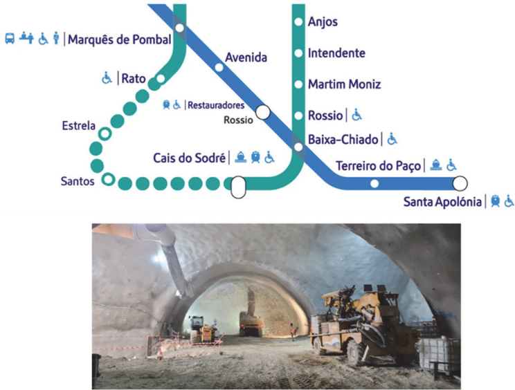
Fig. 9 – Obras iniciadas no Metropolitano de Lisboa.
