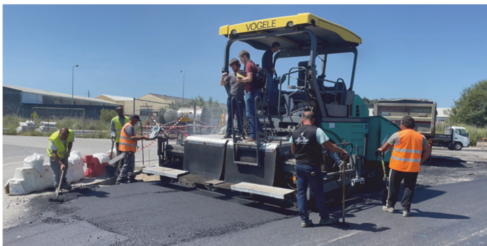
Fig. 14 – Experiências de incorporação de uma câmara térmica em pavimentadora.
