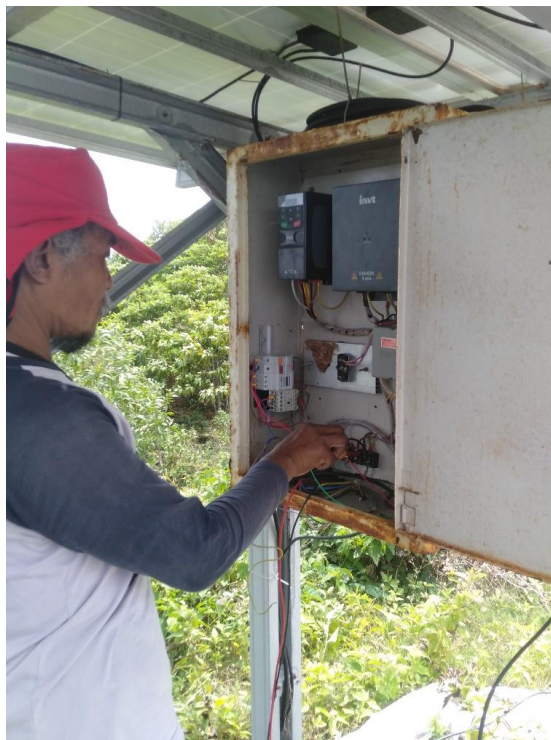
Gambar 6 Hasil instalasi kelistrikan Sistem Panel Surya
