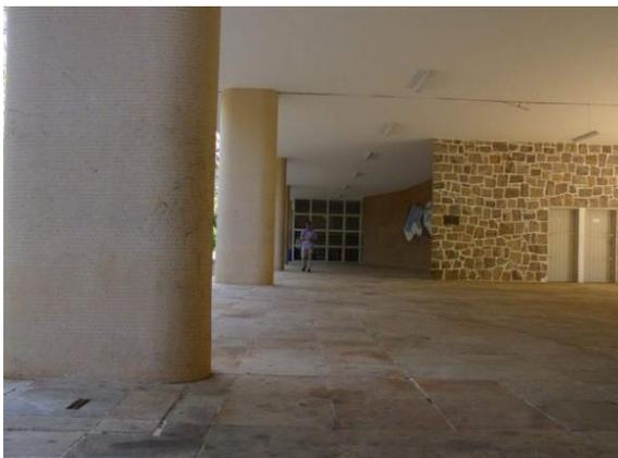
**Figura 2** - Foto da lateral do Colégio Cataguases destacando seus pilotis. Fonte: Acervo das autoras
