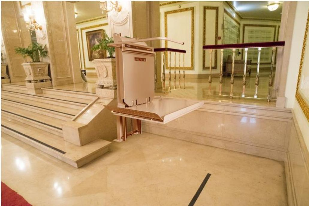
*Figura 4 - Aspecto final da plataforma elevatória introduzida no Salão Nobre, com o estrado alinhado com o nível do corredor de acesso. Fotografia de Pedro Fidalgo.*
